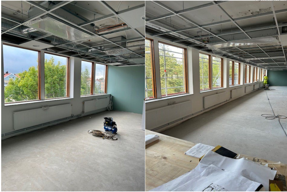
Fönsterbänkar monteras och draging av installationer
