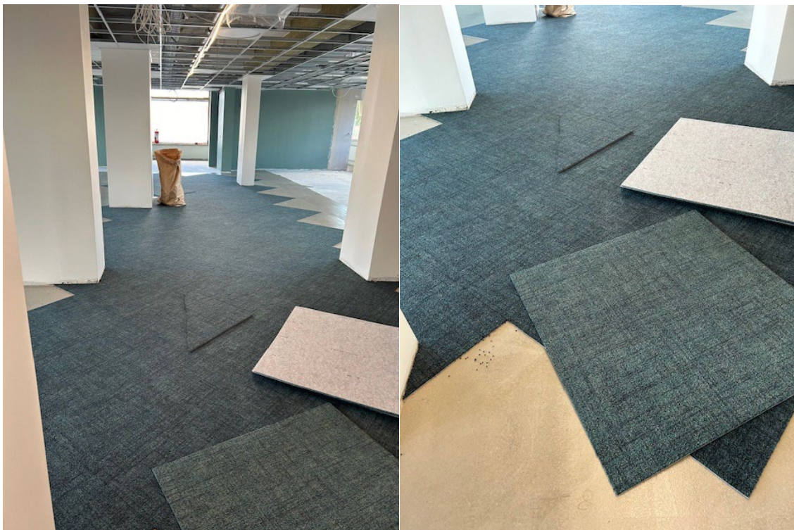
Mattläggning och belysning installeras
