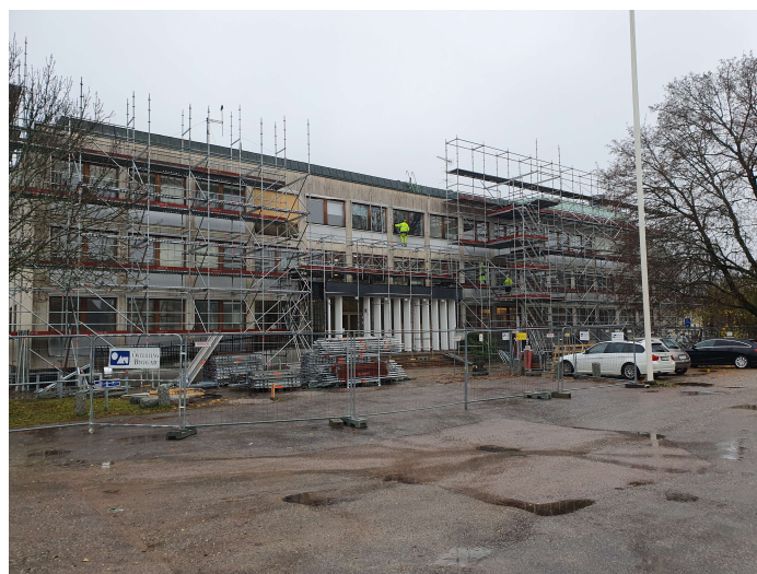
På bilderna syns det pågående ställningsarbetet
