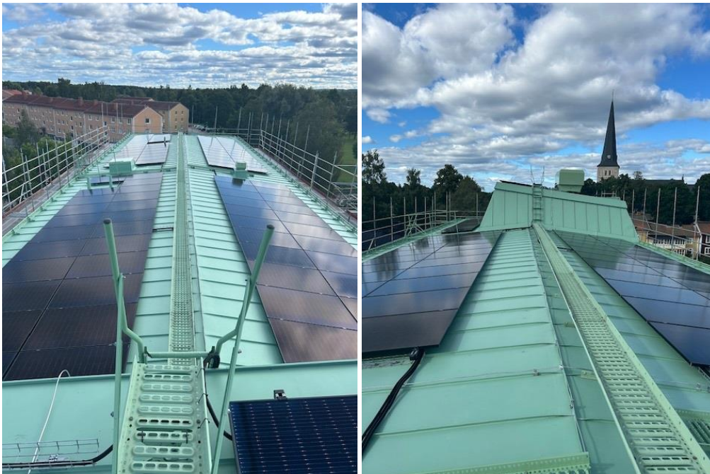
Solceller och taksäkerhet färdigställt
