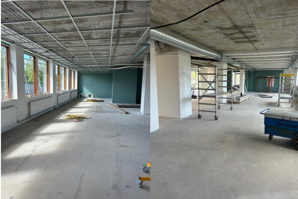
Målningsarbete pågår och installation av undertak stundar
